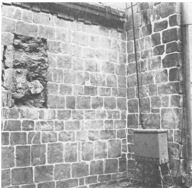
43. Telč, kostel sv. Ducha, styk věže a lodi na jižní straně po odstranění obezdívky
