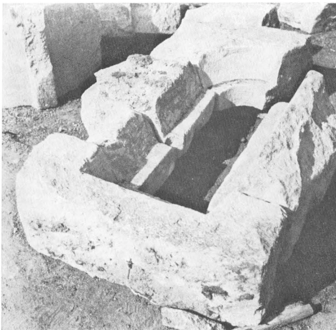
42. Telč, kostel sv. Ducha, rekonstrukce románského okna
