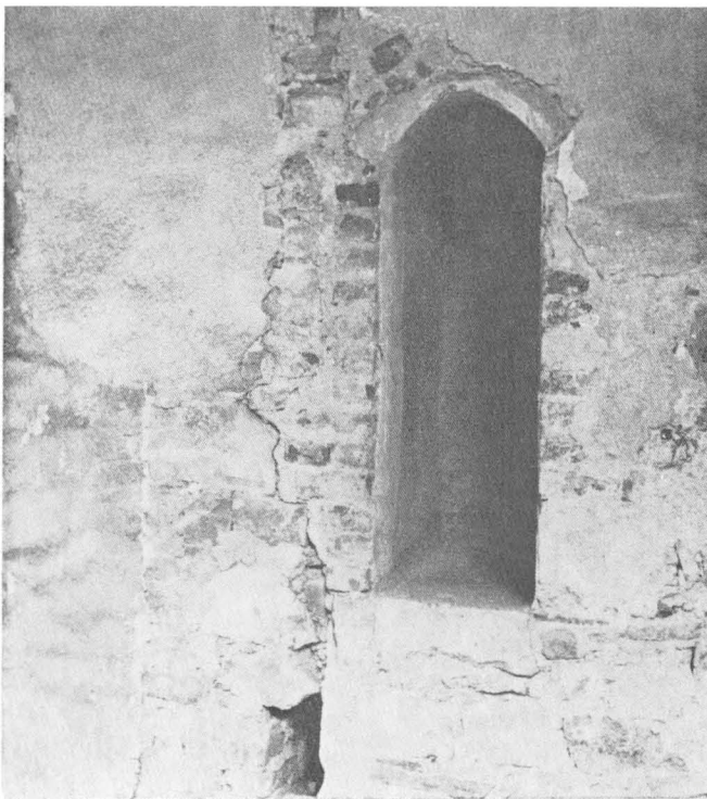
41. Oslavany, býv. klášterní kostel, odkrytá komunikace v síle zdiva na jižní straně presbytáře
