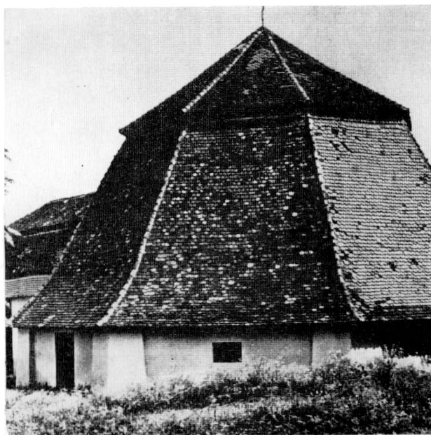
25. Prešov-Solivar. Šachta Leopold.
