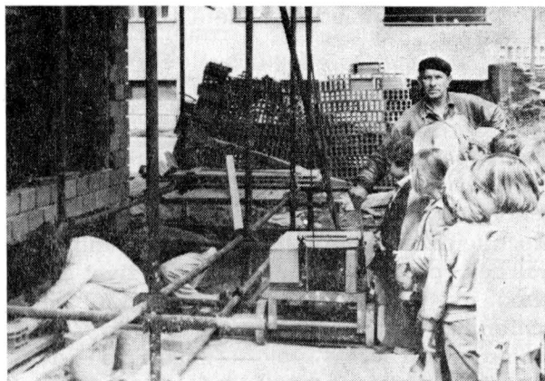
Obr. 81. Stavební práce a účast malých diváků
