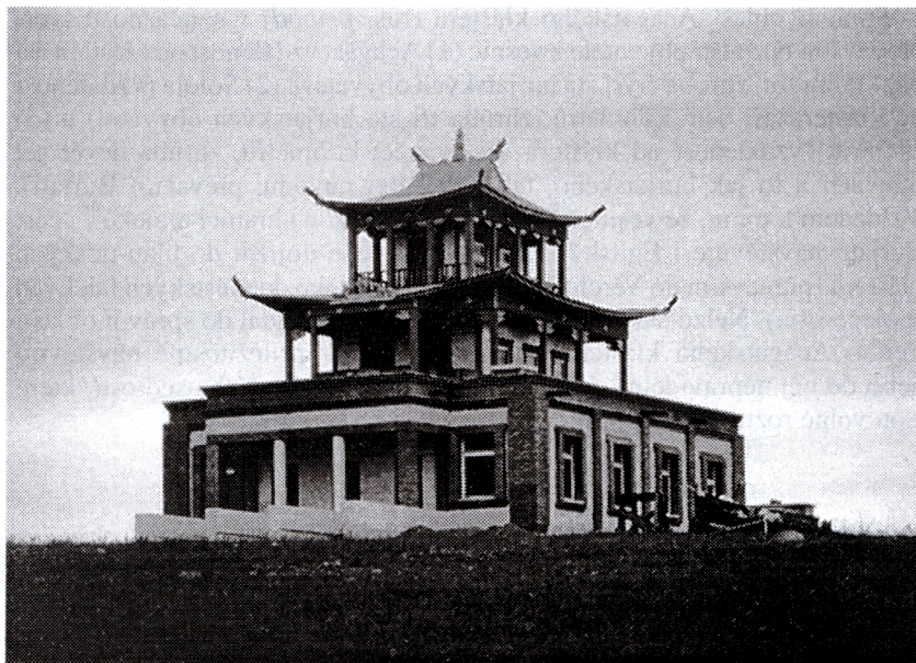
Třetí Acagatský klášter, pohled z jihovýchodu, stav v roce 1994.
