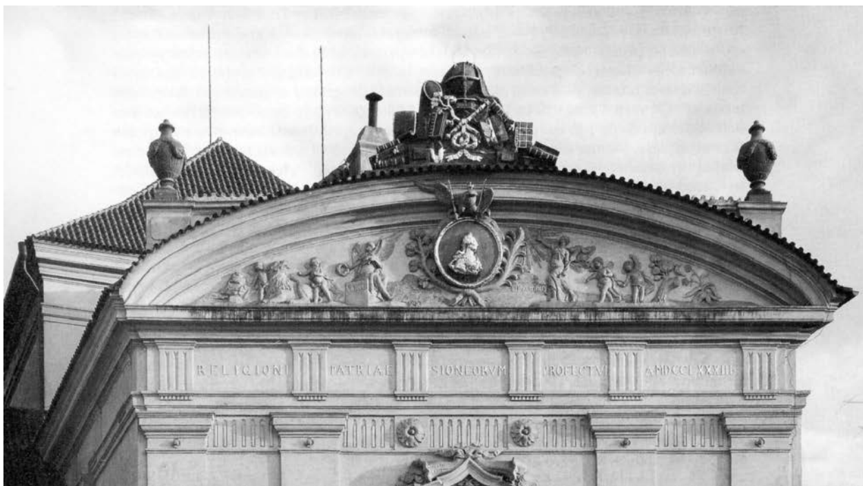
4 – Ignác František Platzer, Sochařská výzdoba průčelí knihovní budovy s tzv. Filosofickým sálem , 1783. Praha, klášter premonstrátů na Strahově
