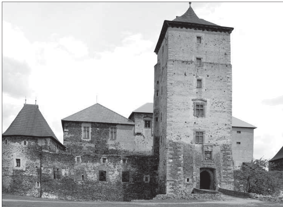
Obr. 1. Pohled na vstupní průčelí jádra hradu Švihova s tzv. Červenou baštou. Abb. 1. Blick auf die Eingangsfassade der Kernburg Schwihau mit sog. Roter Bastei.
