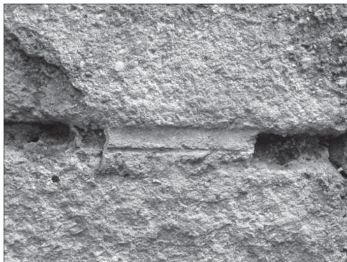
Obr. 3. Hrad Lukov, detail fragmentu omítky, v níž je vytlačena linka – spára. Foto R. Vrla, 2004.
