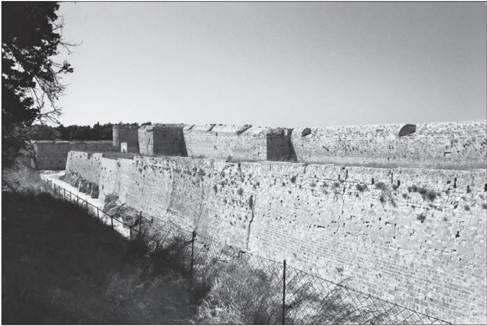
Obr. 14. Obezdný val (terreplein) v příkopu mezi branou Koskinou a Anglickou baštou. Abb. 14. Ummantelter Wall (Terreplein) im Graben zwischen Johannestor und der englischen Bastion.
