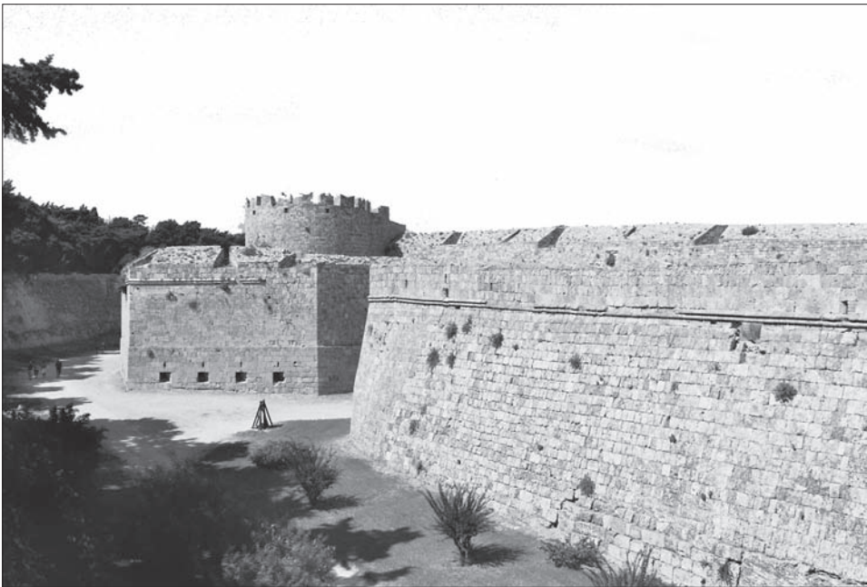
Obr. 13. Španělská věž s bollwerkem a kleště od jihu.
