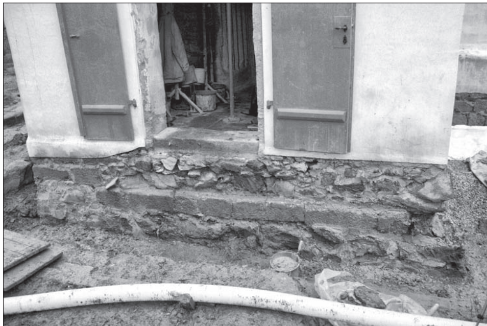
Obr. 5. Bukovec, okr. Domažlice, kostel Nanebevzetí Panny Marie. Zdivo románské přístavby použité jako základ barokní předsíně. Foto M. Čechura, 2009.
