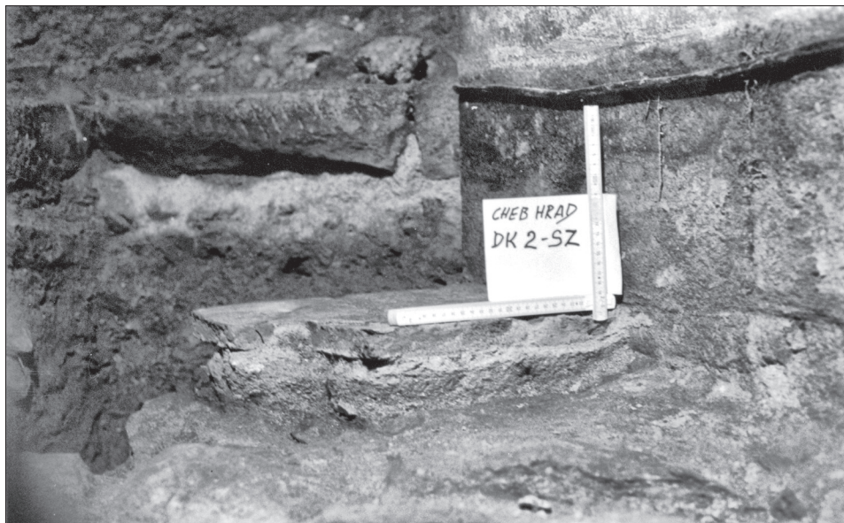
Obr. 8. Cheb, hrad. Románská maltová podlaha v dolní kapli byla vytažena přes základ schodiště vedoucího do horní kaple. Foto P. Šebesta, 2000.
