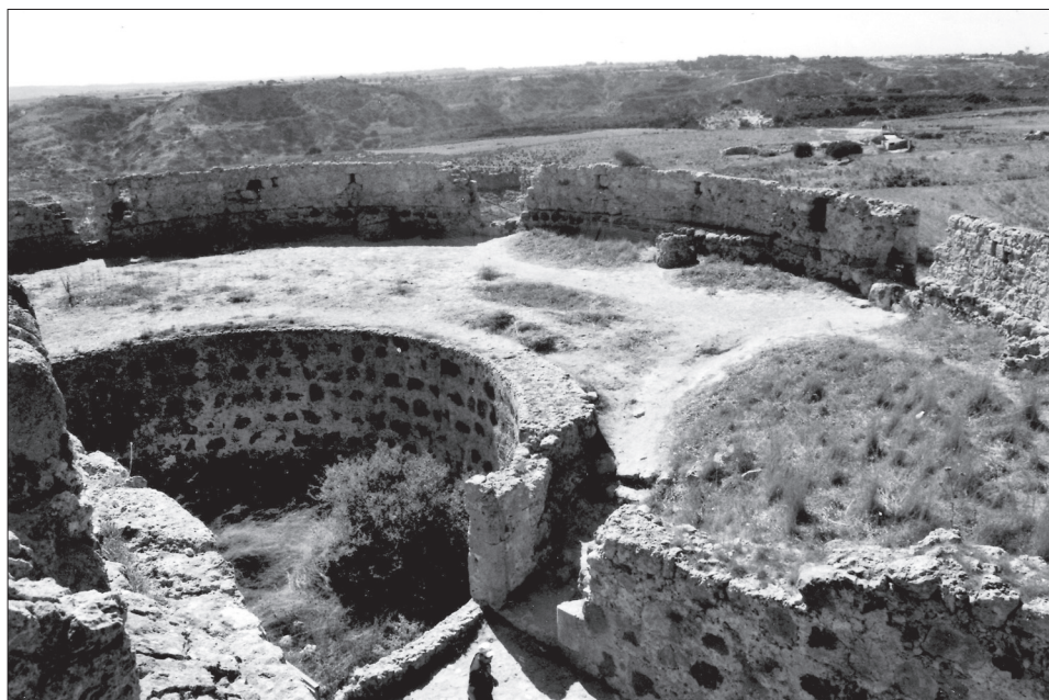
Obr. 8. Antimacheia, interiér rondelu od jihovýchodu se zděnými komínky dýmníků z dělových komor. Abb. 8. Andimachia, Innenansicht des Rondells von Südosten mit steinernen Rauchabzügen der Kanonenkammern.
