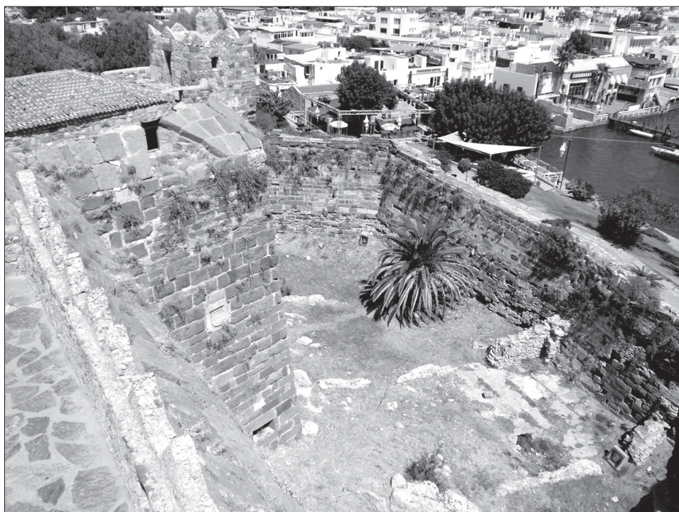
Obr. 17. Bodrum, detail opevnění severovýchodního nároží vnějšího pásu fortifikace. Abb. 17. Bodrum, Befestigungsdetail der Nordostecke des Befestigungsaußenstreifens.
