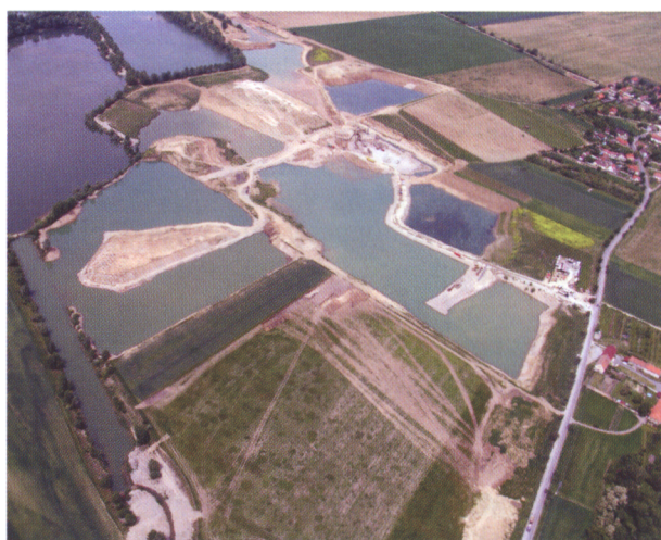
Obr. 2: Vlíněves. Letecký pohled na zkoumanou lokalitu (červen 2006) (Foto M. Gojda).
