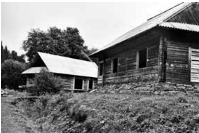
39. Rozestavěné srubové domy na Zakarpatí – Foto DK, 2002.
