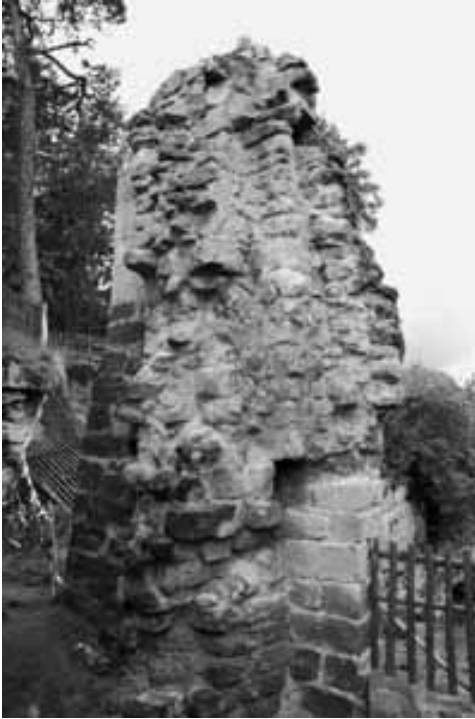
Obr. 5. Valdštejn (okr. Semily). Nároží stavby s výběhem zdiva východním směrem k starší zástavbě hradního jádra, v destrukci hloubkové obvodové zdi patrné kapsy po dolním i horním systému výztuh. Foto I. Peřina, 2007.
