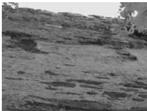
Obr. 13. Cimburk u Městečka Trnávky. Detail otisků dřevěné konstrukce pozdně gotického ochozu na severním obvodu jádra. Foto J. Štětina, 2007.
