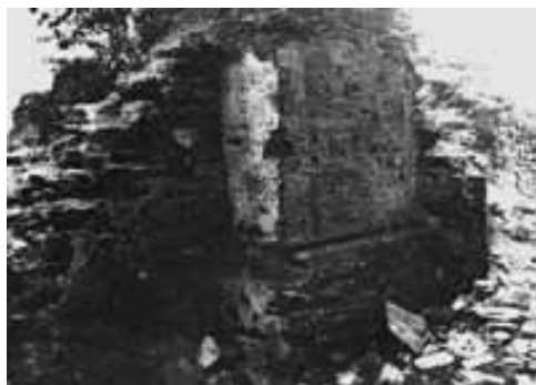
Obr. 14. Cimburk u Městečka Trnávky. Severní strana pilíře před západním křídlem s omítkovým kvádrováním. Vlevo přiléhá dnes zaniklá zeď. Foto archiv NPÚ, ú. o. p. v Brně.
