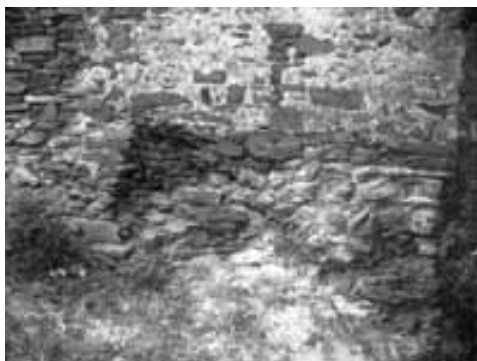
Obr. 12. Cimburk u Městečka Trnávky. Severovýchodní nároží jádra se začleněným starším zdivem, převrstveným pozdně gotickými, v nároží provázanými zdívy severního a východního křídla. Foto J. Štětina, 2007.
