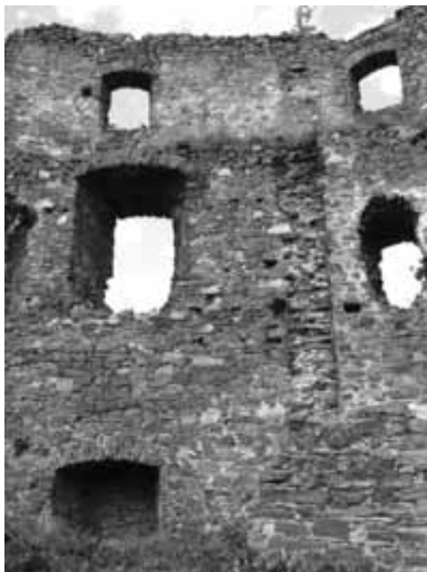
Obr. 9. Cimburk u Městečka Trnávky. Vnitřní líc severní obvodové zdi jádra. Vlevo předpokládané zdivo starší palácové stavby s výběhem interiérové příčky, vpravo pozdně gotická dostavba. Foto J. Štětina, 2007. Abb. 9. Cimburk bei Městečko Trnávka. Innenflucht der Nordringmauer der Hauptburg. Links vermutliches Mauerwerk des älteren Palasbaus mit Auslauf der inneren Trennmauer, rechts spätgotischer Ausbau. Foto J. Štětina, 2007.
