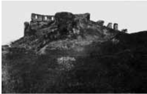
Obr. 5. Cimburk u Městečka Trnávky. Hradní jádro při pohledu z příkopu na počátku 20. století. Vlevo za obvodovou zdi severní torzo, vpravo vyčištěné pozůstatky přízemí západního křídla, v čele jádra vedle mohutného torza obvodové hradby destrukční kužel s výrazným zbytkem obvodové zdi, dále vpravo torzo zdiva brány, zcela vpravo jižní zeď východního křídla s vylámaným oknem v přízemí. Foto archiv NPÚ, ú. o. p. v Brně. Abb. 5. Cimburk bei Městečko Trnávka. Hauptburg, Blick vom Graben zu Beginn des 20. Jhdts. Links hinter der Ringmauer der Nordtorso, rechts die gereinigten Überreste des Westflügel Erdgeschosses, in der Hauptburgfront neben dem mächtigen Torso der Ringmauer der eingestürzte Kegel mit deutlichem Ringmauerrest, ferner rechts der Torso des Tormauerwerks, ganz rechts die Südmauer des Ostflügels mit herausgebrochenem Fenster im Erdgeschoss. Foto Archiv des Nationalen Denkmalamts, Bezirksstelle Brno.
