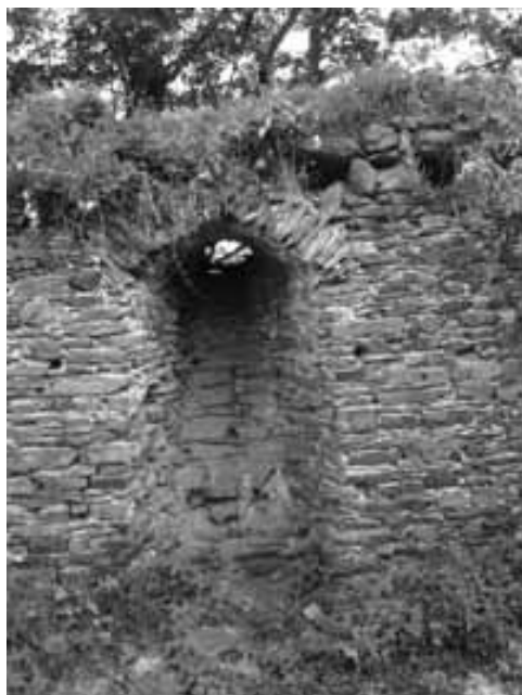
Obr. 15. Cimburk u Městečka Trnávky. Nika jižního okénka v suterénu východního křídla, pod korunou jsou patry kapsy trámového stropu. Foto J. Štětina, 2007. Abb. 15. Cimburk bei Městečko Trnávka. Nische einer Gucklochöffnung im Untergeschoss des Ostflügels, unter der Mauerkrone sind die Taschen der Balkendecke sichtbar. Foto J. Štětina, 2007.
