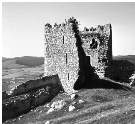
Obr. 10. Spišský hrad. Pohľad na obrannú vežu spodného predhradia (vybudovanú okolo polovice 13. storočia) s posunutými lukovištnými strieľňami a s nadväzujúcim úsekom sekundárne pristavaného opevnenia, so štrbinovou strieľňou z južnej strany veže, stav pred obnovou. Zdroj Archív PÚ SR, fond veľké diapositívy, ev. č. 1653.
