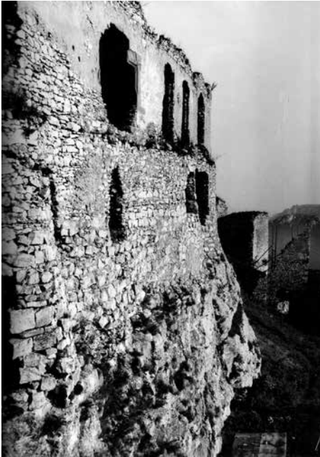
Obr. 5. Spišský hrad. Pohľad na západnú stenu hradného jadra s jasne čitateľným zabudovaným starším opevnením (1. tretina 13. storočia) z riadkovaného kamenného muriva z väčších blokov v spodnej časti, nasadeným na hradnom travertínovom brale a ukončeným v rovine, na ktorej je nasadená mladšia palácová nadstavba. Zdroj Archív PÚ SR, T867-12 neg. 69143, okolo roku 1972.
