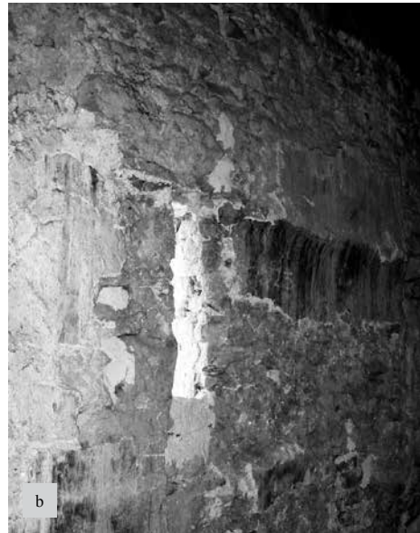
Obr. 18. Bašta – Pracháreň v Levoči (pred obnovou, počas architektonicko-historického výskumu) južná stena so zabudovanou staršou priebežnou hradbou ukončenou cimburím. a – sondou odkryté cimburie zo strany exteriéru – pôvodne ochodze, pod ním zvýšená časť ochodze do podoby zošíkmeného oporného piliera; b – v interiéri – pôvodne na strane priekopy – viditeľná predstúpená časť po kamennej rímsičke nad stenkami zamurovaného cimburia. Foto M. Janovská.
