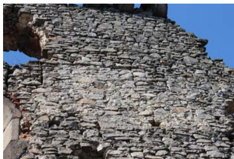
Obr. 17. Hrad Slanec, okr. Košice-okolie. Detail severovýchodnej steny paláca so zamurovaným cimburím a trámov ochodze. Foto M. Šimkovic.
