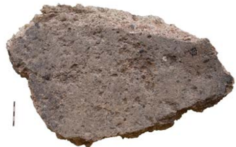
Obr. 6. Hrad Slanec, okr. Košice-okolie. Fragment silnej maltovej dlážky z Rezu 2. Foto R. Rusnák.
