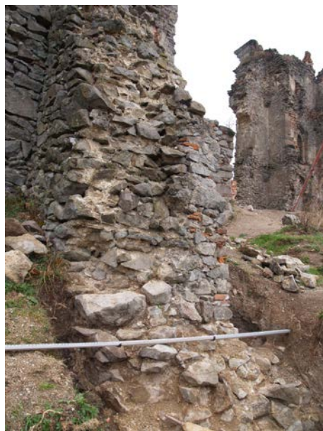
Obr. 8. Hrad Slanec, okr. Košice-okolie. Sonda 12/13. Odkryté napojenie najstaršej vnútornej hradby na vežu. Foto R. Rusnák.
