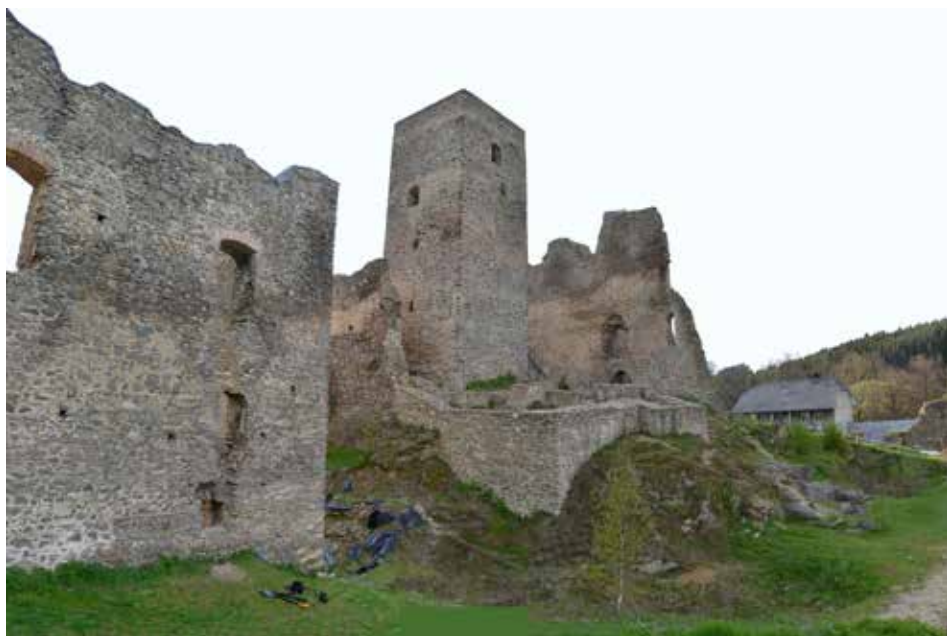
Obr. 1. Hrad Rokštejn. Pohled na horní hrad od jihovýchodu z prostoru dolního nádvoří. Pod nárožím hradby horního hradu je do skály vylámaný příkop (obj. 84) s viditelnými terénními vlnami a vyzníváním příkopu na východní straně (na obrázku vpravo). Foto J. Mazáčková.
