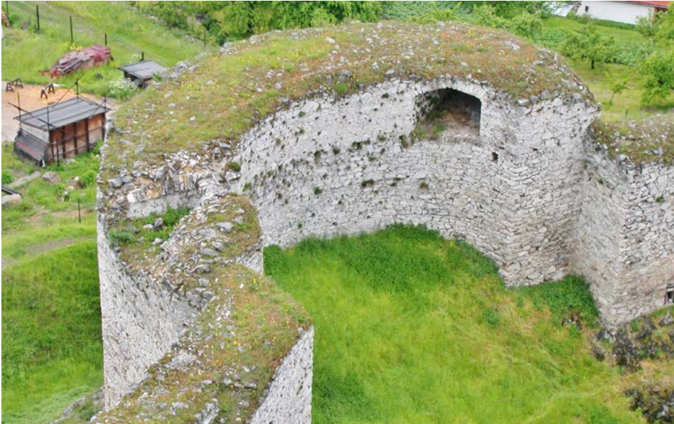
Obr. 11. Hrad Rabí, okr. Klatovy. Zevně polygonální bašta vnějšího opevnění na západní straně, k níž se kurtiny připojují takřka „na střih“. Foto J. Varhaník, 2004.
