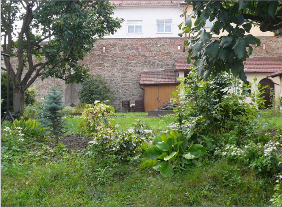
Obr. 5. Hradba na severovýchodě města zvenčí. Foto M. Plaček. Abb. 5. Stadtmauer im Nordosten der Stadt von außen. Foto M. Plaček.
