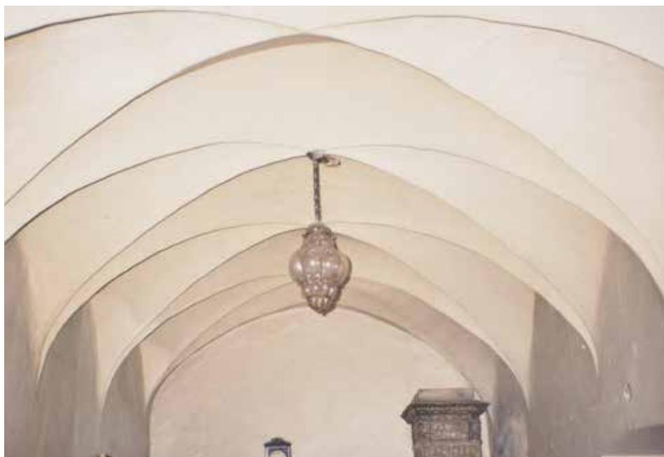
Obr. 12. Hrad Orlík, okr. Písek. Jednoduchá sklípková klenba v přízemí severozápadního křídla. Foto J. Varhaník, 1997. Abb. 12. Burg Orlík, Bezirk Písek. Einfaches Zellengewölbe im Erdgeschoss des Nordwestflügels. Foto J. Varhaník, 1997.
