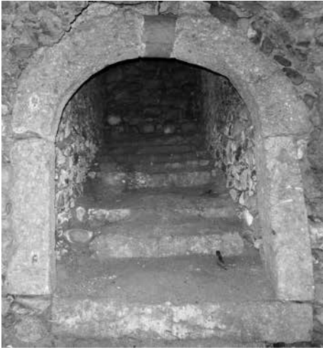
Obr. 10. Krupina, Partizánska ulica 5. Vstupný portál do štólne pivnice – príklad typického vstupného portálu, aký sa opakuje na všetkých zdokumentovaných objektoch. Foto M. Miňo.
