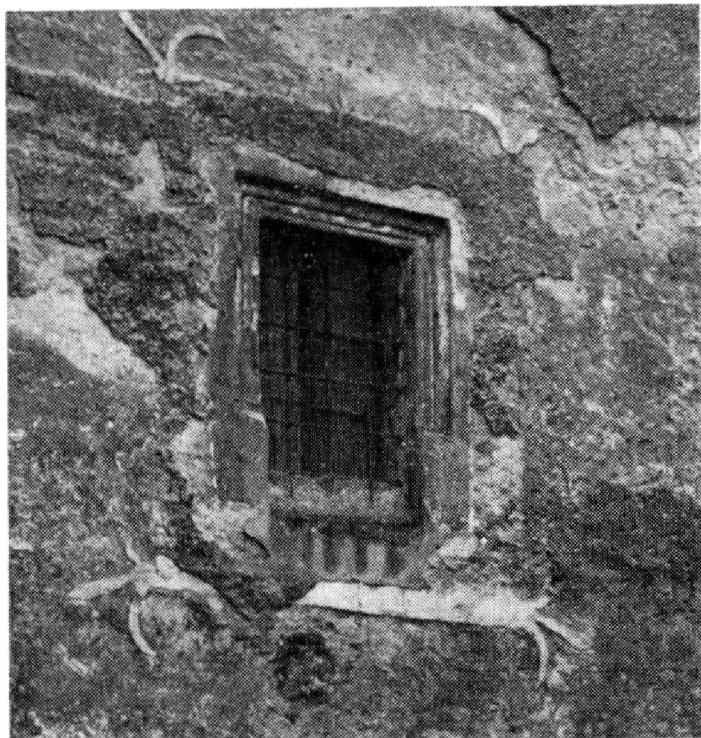
Obr. 7. Popovice – dochovaná pozdně-gotické ostění s paspartou v pravé polovině severního průčelí tvrze (foto F. Kajička).
