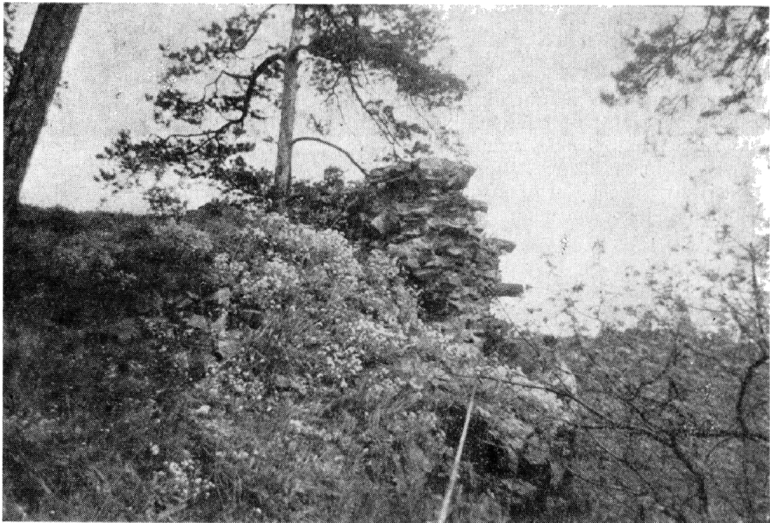
Obr. 4. Hrad Kozlov – dochované obvodové zdivo, pohled od J.
