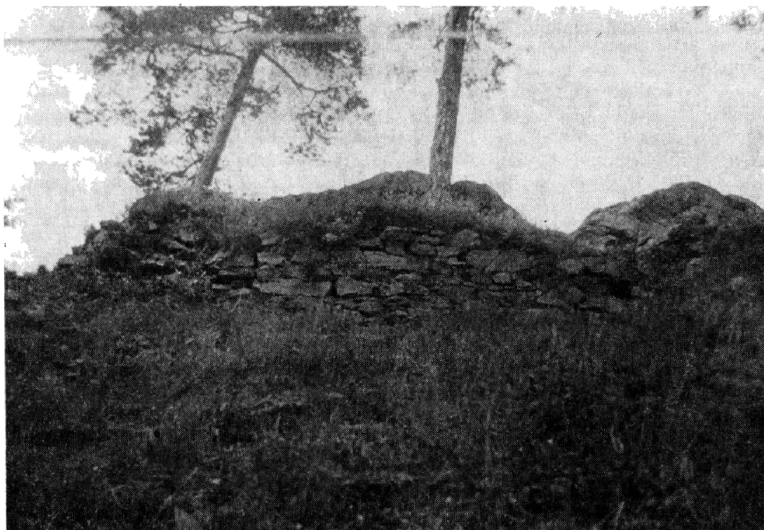
Obr. 5. Hrad Kozlov – vnitřní zidka (příčka), pohled od J.
