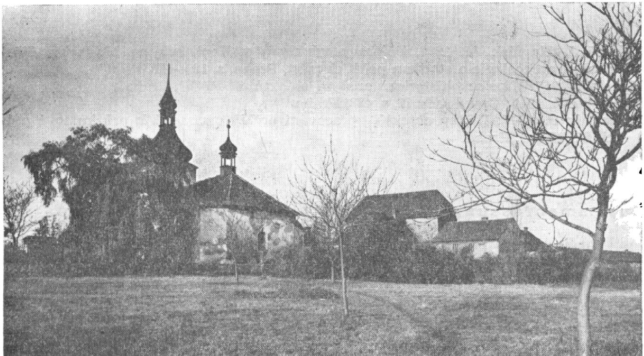
Obr. 6. Pohled na kostel a tvrz v Kopistech od východu, stav 1978 (foto K. Wartha).
