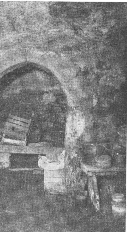
Obr. 9. Bolevec čp. 1. Portál do většího pravého (východního) sklepa, sestavený z částí ostění zřejmě dvou pozdně gotických portálů.
