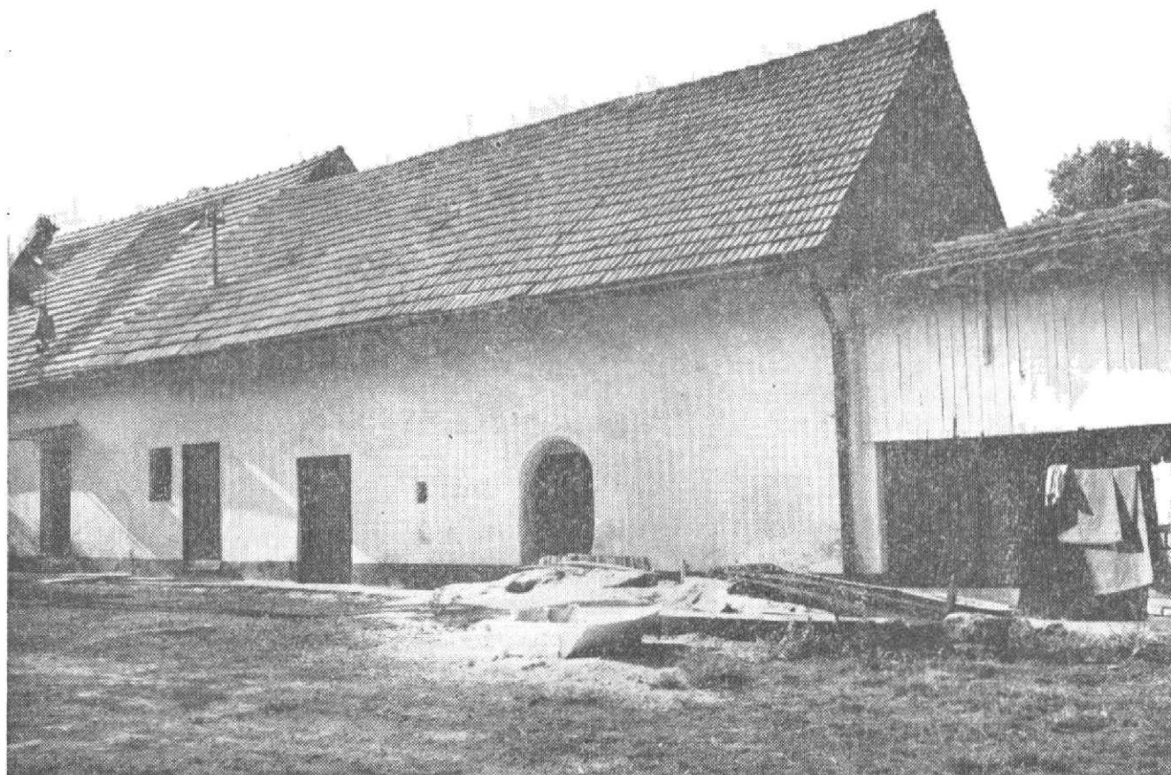
Obr. 4. Božkov čp. 15. Celkový pohled na sýpku za domem, se vstupním pozdně gotickým okoseným portálem s půlkruhovou archivoltou.
