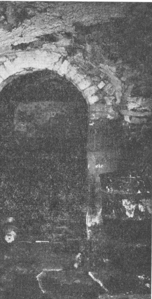
Obr. 8. Bolevec čp. 1. Portál do menšího levého (západního) sklepa, sestavený nepochybně při výstavbě domu na začátku 19. století s použitím svislých částí ostění pozdně gotického portálu. Archivolta byla doplněna z cihel.
