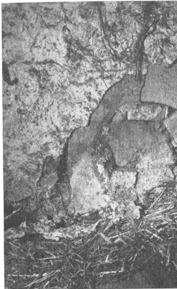
Obr. 11. Bolevec čp. 7. Ostění kruhového okoseného větracího okénka v západní štítové stěně sýpky. Okénko bylo zřejmě zazděno a omítnuto při klasicistní úpravě sýpky na začátku 19. století.
