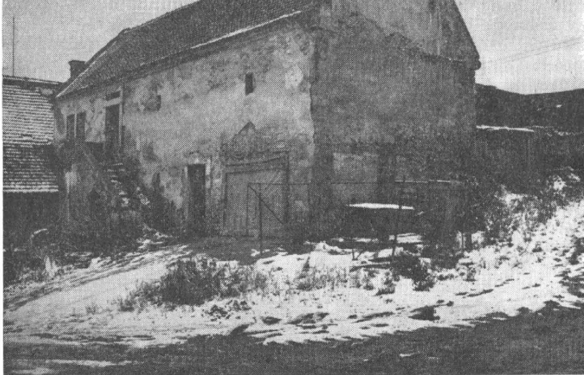
Obr. 16. Bolevec čp. 19. Klasicistní sýpka ze začátku 19. století ve dvoře usedlosti. Ve zdivu nároží je možné sledovat druhotně zabudované části středověkého okoseného ostění. Ve vrcholu štítu je větrací okénko profilu křížkové střílny, levé z dvojice okének pod ním má okosené ostění pozdně gotického tvaru.
