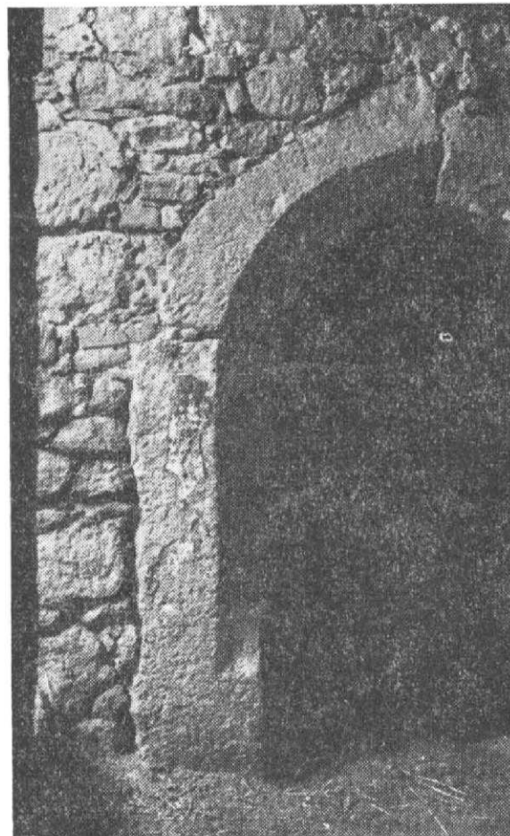
Obr. 12. Bolevec čp. 7. Jižní z dvojice nepochybně druhotně osazených portálů ve sklepech při zadní části domu: goticko-renesanční s půlkruhovou archivoltoou, s mělkým a širokým, dále pravouhle ukončeným okosením.
