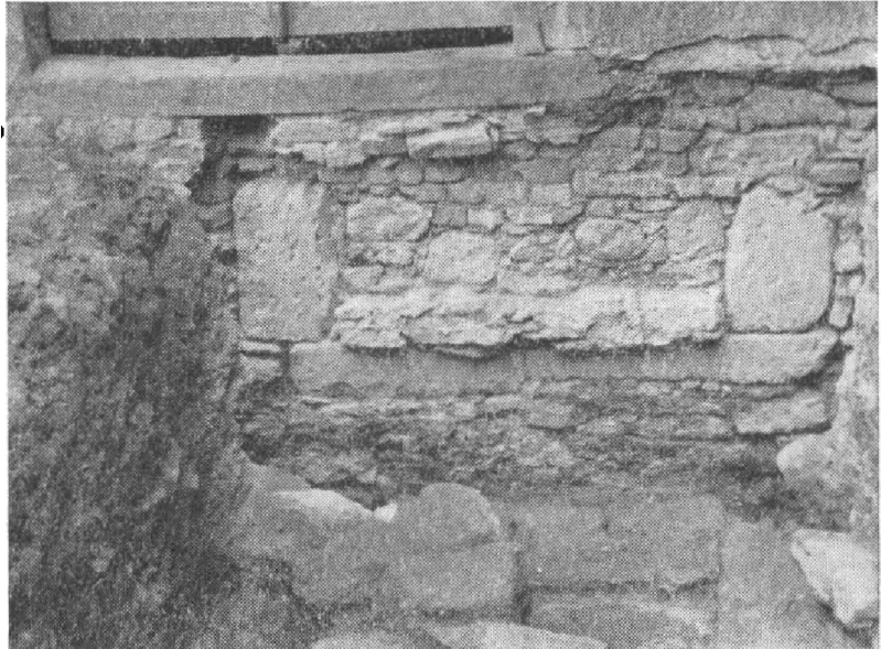
Obr. 4. Holíč-kaštieľ, fragment kamenného portálu v severnom múre staršieho gotického paláca. Foto D. Tóth.
