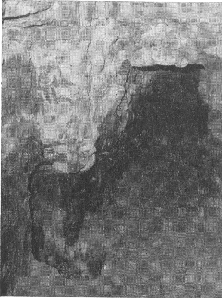
Obr. 7. Holíč-kaštieľ, odkrytá podzákladová pilotáž neskorogotického paláca. Foto D. Tóth.
