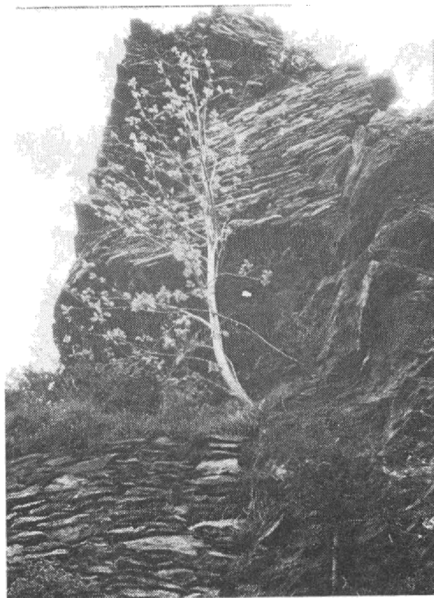
Obr. 6. Hrad Koberštejn, torzo palácové stavby a zbytky zdiva pod skálou.
