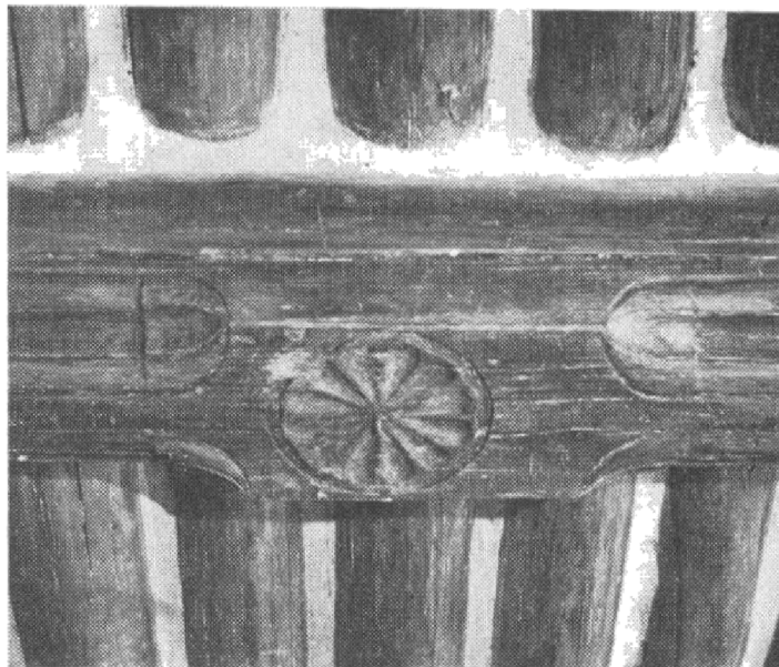
Obr. 10. Praha, bývalá radnice Podskali na Výtoni. Detail zdobného středu trámu pod povalovým stropem velké obytné místnosti ze 16. století.
