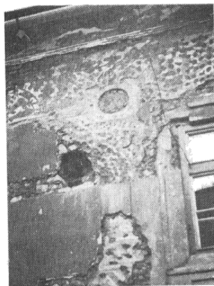
Obr. 13.–14. Banská Štiavnica (okres Žiar nad Hronom). Drobné větrací otvory čtvercového a kruhového tvaru v průčeli domů.
