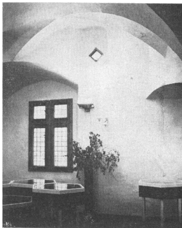
Obr. 11.–12. Kremnica (okres Žiar nad Hronom). Příklady větracích otvorů ve slěnách pozdně gotických domů – šikmé průrazy s omítkovými paspartami a situace otvoru v prostoru, klenutém sklípkovou klenbou.
