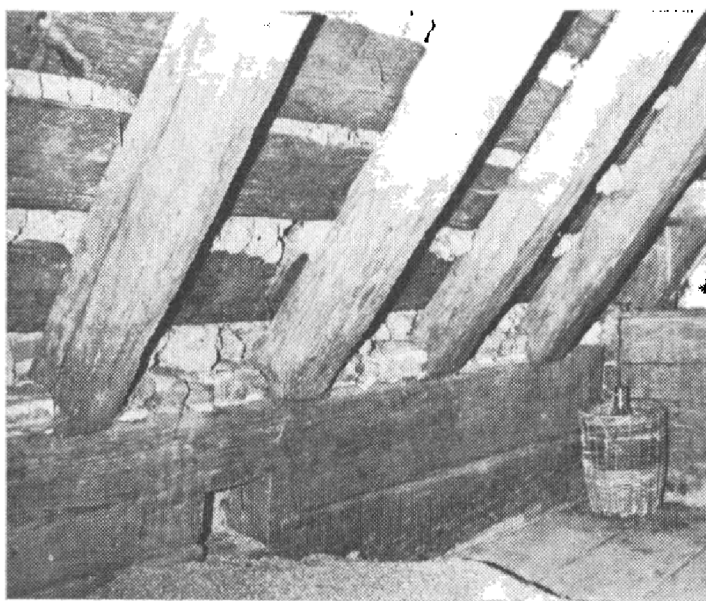
Obr. 4.–5. Krnin řp. 3 (okr. Český Krumlov). Izolační dřevohliněná konstrukce (lepenec) v podstřeší zadní patrové komorové části pozdně gotického domu – usazení krokví, nosoucích bednění a mazaninu, na roubeném věnci, a pohled vzhůru ke hřebeni střechy mezerou mezi vnějším licem hliněné izolace a vrchním krovem s krytinou.
