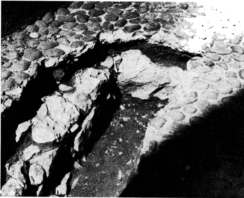
Obr. 4. Zvolen — zámok. Styk základov pôvodnej čelnej steny polygónu a základov oporného pilleru č. 4.
