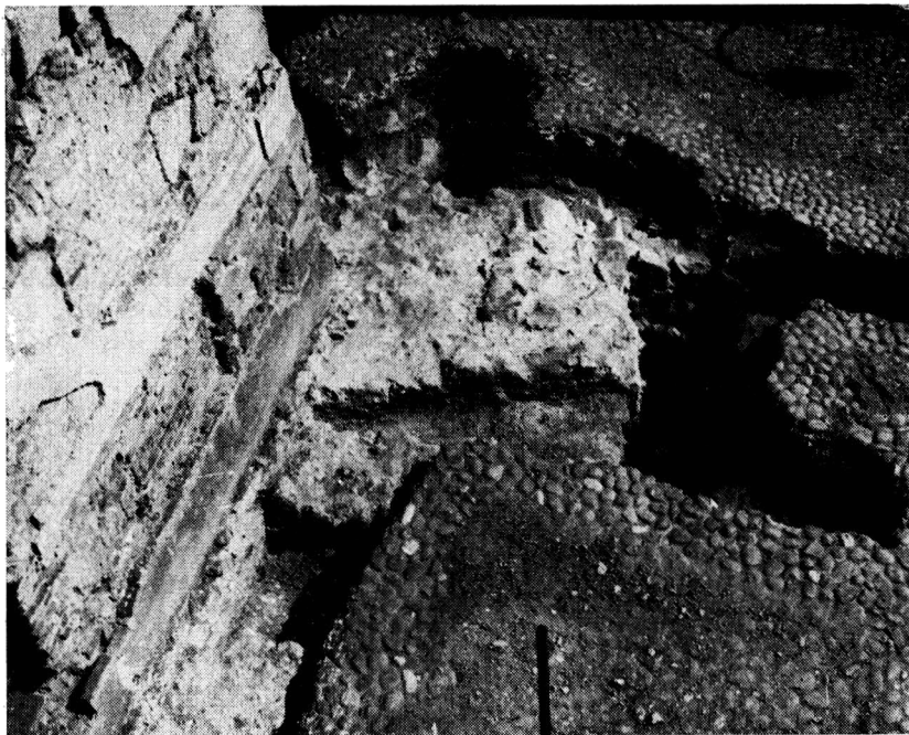
Obr. 2. Zvolen — zámok. Južná stena kaplnky s oporným pilierom č. 2 a so základmi č. 6.
