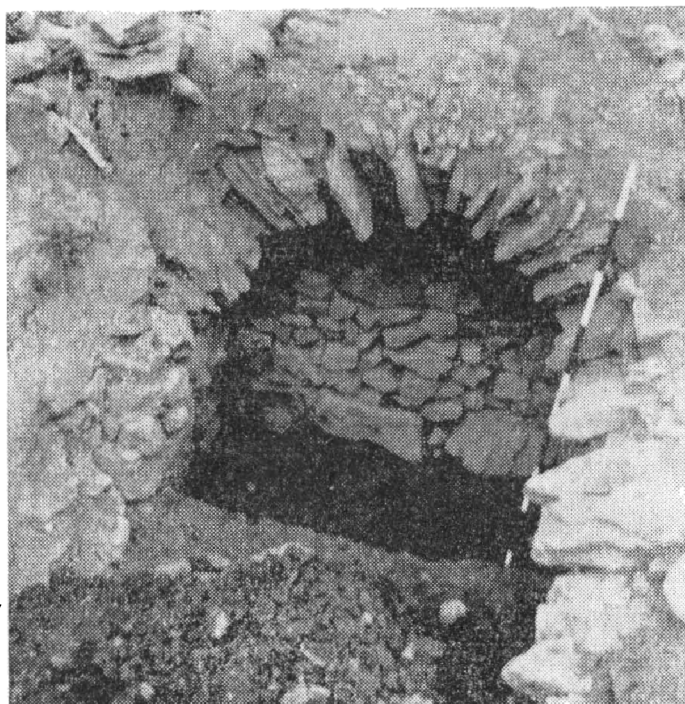
Obr. 5. Zaniklá středověká ves Mstěnice. Sklepni prostor v domě XII. Foto V. Nekuda.
