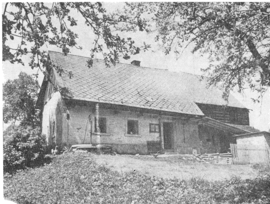
Obr. 8. Budikov čp. 3 (okr. Liberec), celkový pohled. Vpravo díl patrových komor s novodobými okny.
