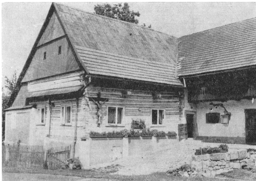
Obr. 7. Petrašovice čp. 26 (okr. Liberec), obytná místnost bývalé rychty pochází v roce 1695. Mezi okny okapové stěny dochované želo polenice.
