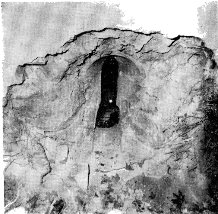
Obr. 4. Vnější špaleta tétož okna.
