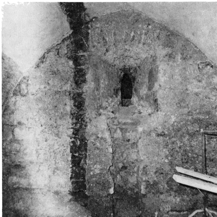
Obr. 5. Severní okno východní stěny velkého sálu s drahotně vylámanou větrací šachtou.
