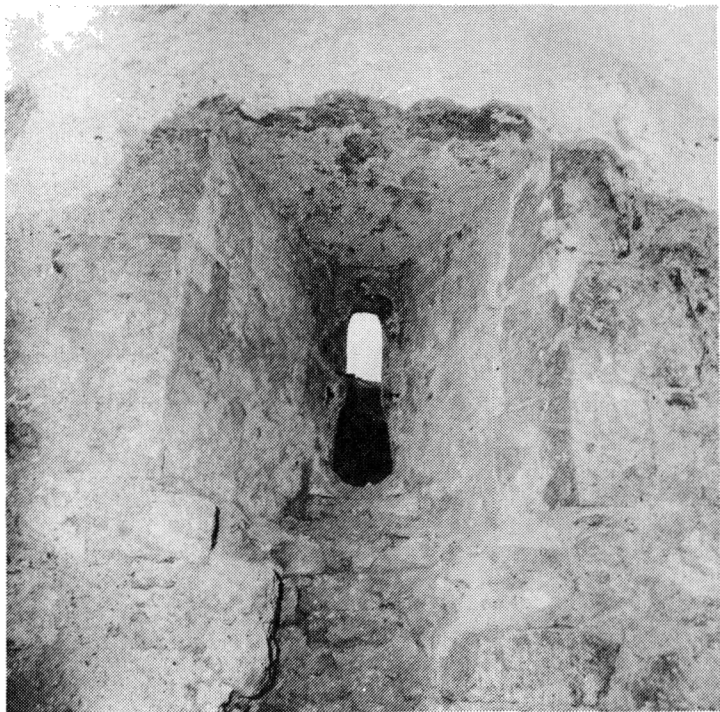
Obr. 3. Vnitřní špaleta jižního okna ve východní stěně sálu.
