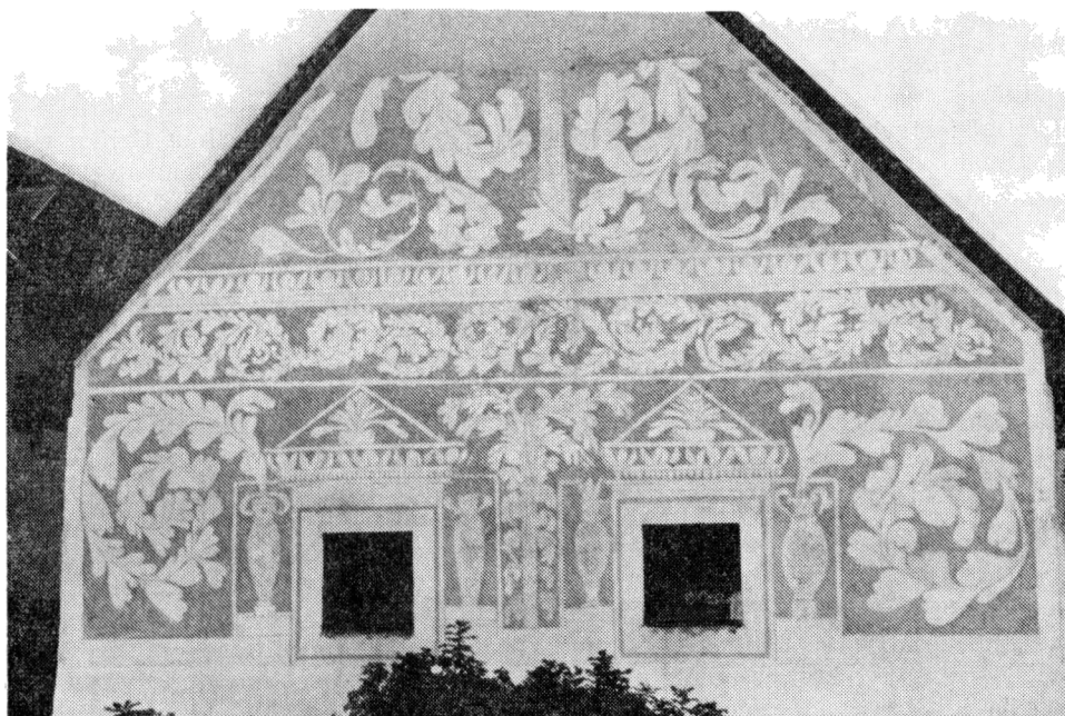
Obr. 8. Holešice, o. Písek, východní průčelí obytné stavby dvorce v roce 1992.
