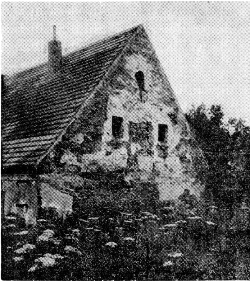
Obr. 13. Vrhavěč, východní průčelí renesanční tvrže, stav roku 1993 (foto J. Úlovec).
