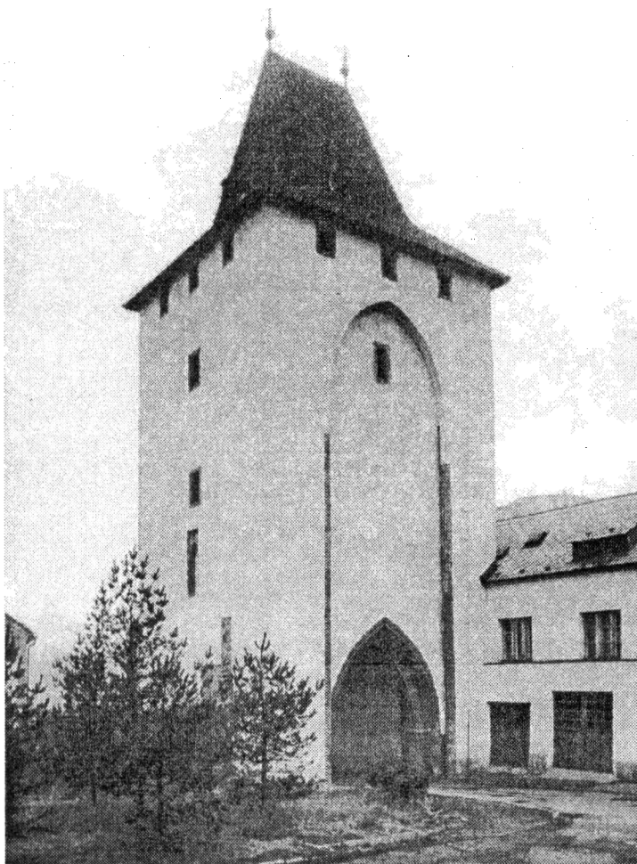
Obr. 8. Městské brány u nás zpravidla nepředstavovaly funkční vrchol aktivních možností pevnostních systémů, ale akcentovaly spíše účel refugiální. Beroun, Dolní brána. Na boční straně brány analyticky obnažen otisk odbourané hradby, vysoko nad ním portálek do prvního patra, uzavíraný padacím můstkem. Foto L. Bezděk 1991.
