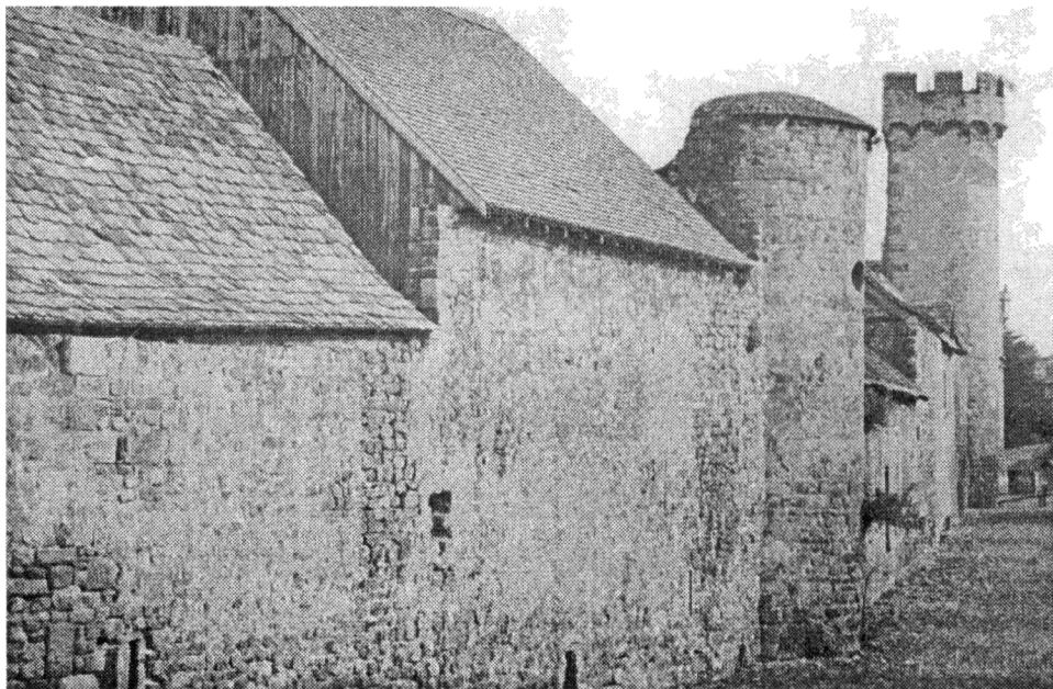
Obr. 4. Pro většinu městských opevnění v rámci Sv. říše římské do doby husitské je příznačné malé rozvinutí flankovacích schopností hradebních věží. Obernai, Alsasko ve Francii, konec 13. století. Foto autor 1993.
