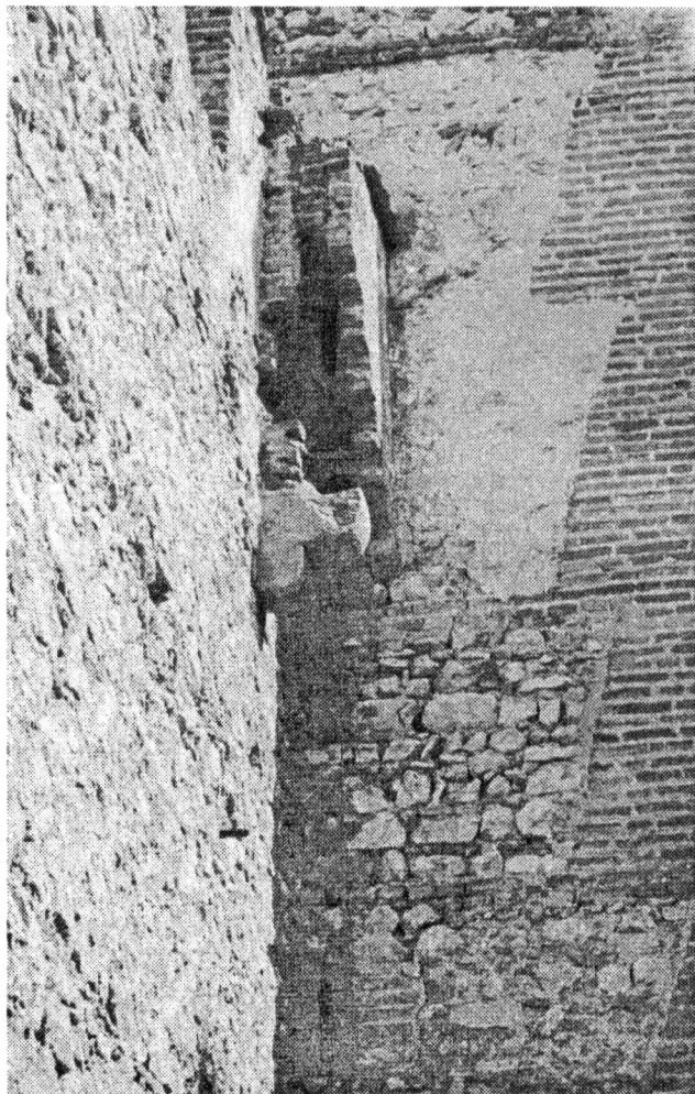
Obr. 7. Kromě případů věží dodatečně připojených k městské zdi se lze setkat i s opačnými příklady, kdy hradební kurtiny byly dodatečně vkládány mezi věže. Přitom může jít prokazatelně o jednotný stavební záměr s těsnou časovou návazností, jako v tomto případě.
