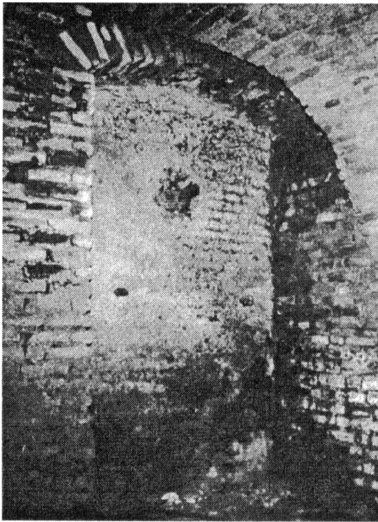
Obr. 4. Pôvodný vstup do 1. podlažia, neskôr zamurovaný. Foto P. Frátrič.
