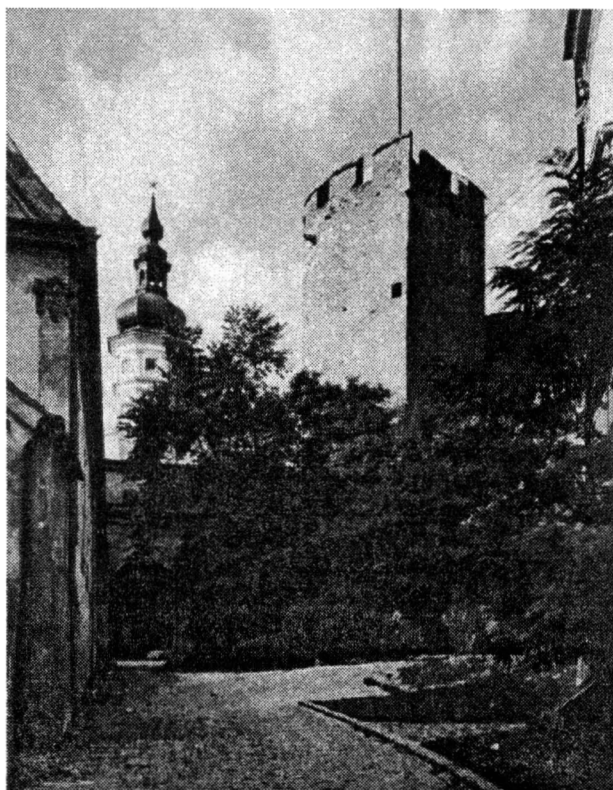
Obr. 3. Mikulov, břítová věž od jihovýchodu. V úrovni přízemí vlevo vstupní portálek ve vpadlině pro padací můstek, nad ním okénko schodiště v síle zdi do 1. patra. Foto Č. Šíla, 1971, archiv SÚPP.
