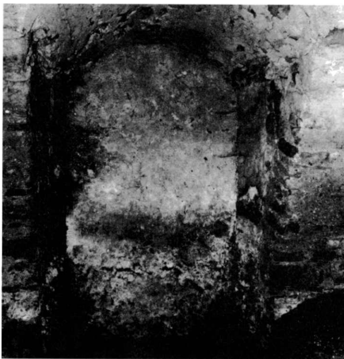
Obr. 10b (dole). Zvyšky zamurovaného portálu interiérovej strany severozápadného múru stavby I i I. Foto K. Rejholec.
