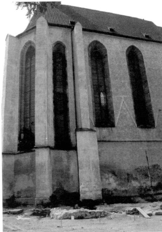
Obr. 4. Severní chórová kaple po úplném odkrytí základů. A – kaple sv. Markéty, B – kvadratická novověká přístavba, C – opěrák závěru 1. gotické fáze.
