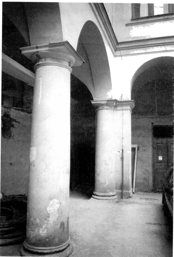
Obr. 13. Pražský hrad – dochovaný úsek renesanční arkády v přízemí nádvoří bývalého Rožmberského paláce (foto Kašička).
