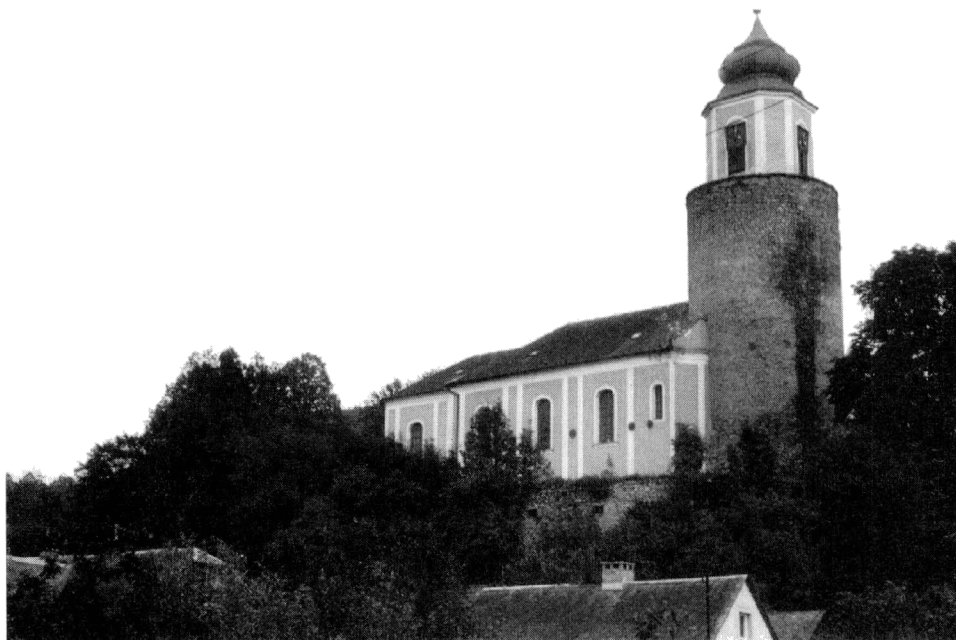
Obr. 24. Žulová. Pohled z náměstí na farní kostel sv. Josefa (bývalý hrad), stav v roce 1986.
