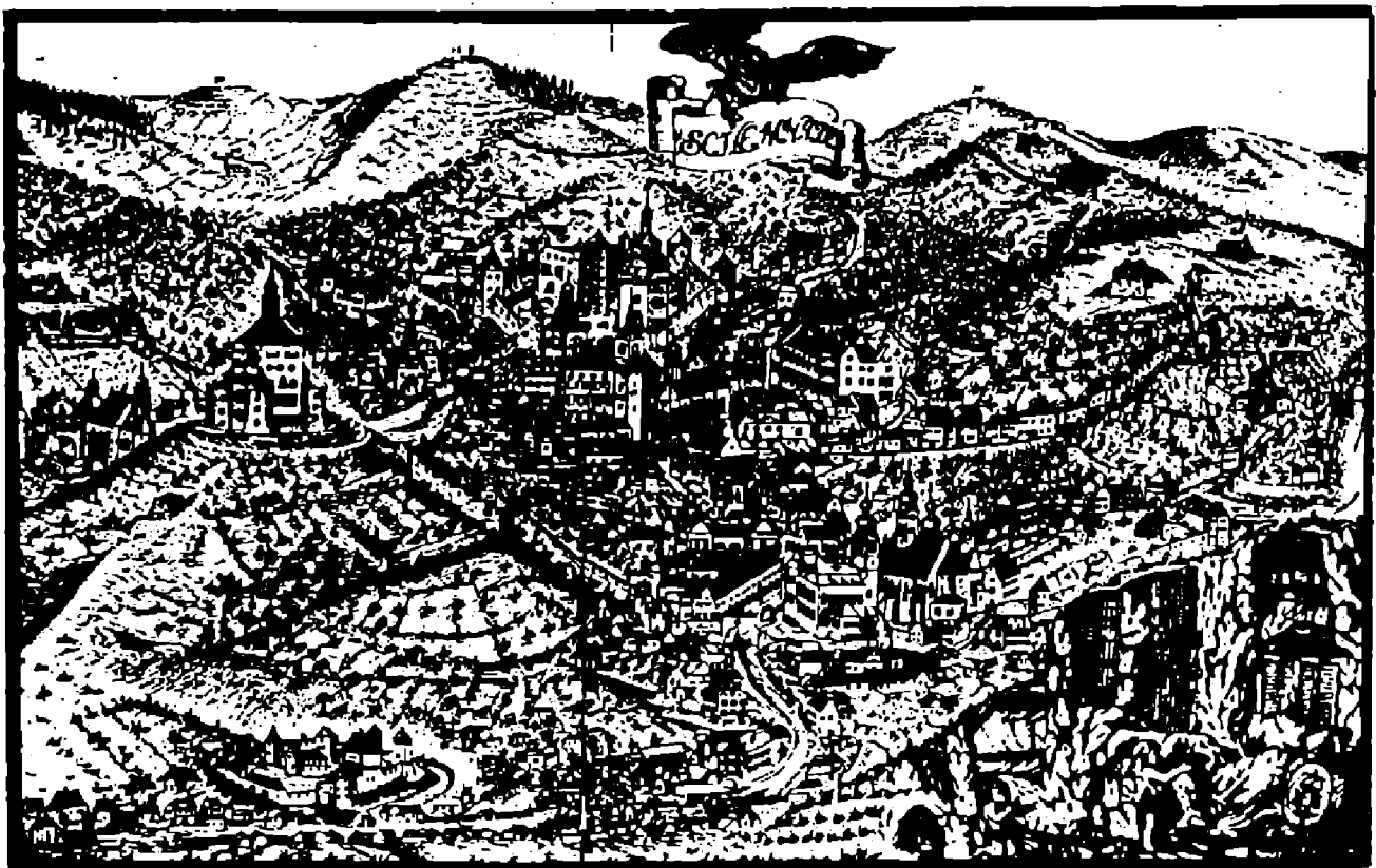
Obr. 2. Banská Štiavnica na vedute J. T. della Martina z r. 1763.
