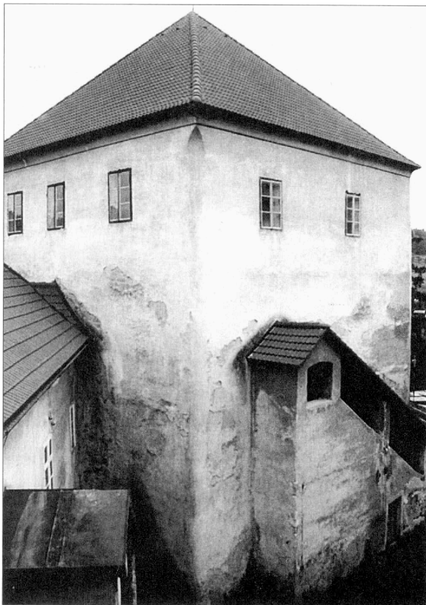
Obr. 8. Vimperk hrad, okr. Prachatice. Vlčková věž v pohledu od východu.
