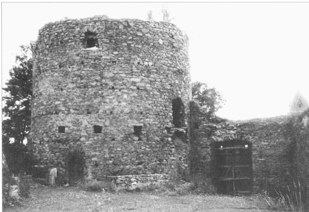
Obr. 10. Vimperk hrad, okr. Prachatice. Předsunutá bašta Haselburg, nádvoří strana bateriové věže s pozůstatky ochozu v patře a čelní zdi s bránou. Všechna foto T. Durdík.
