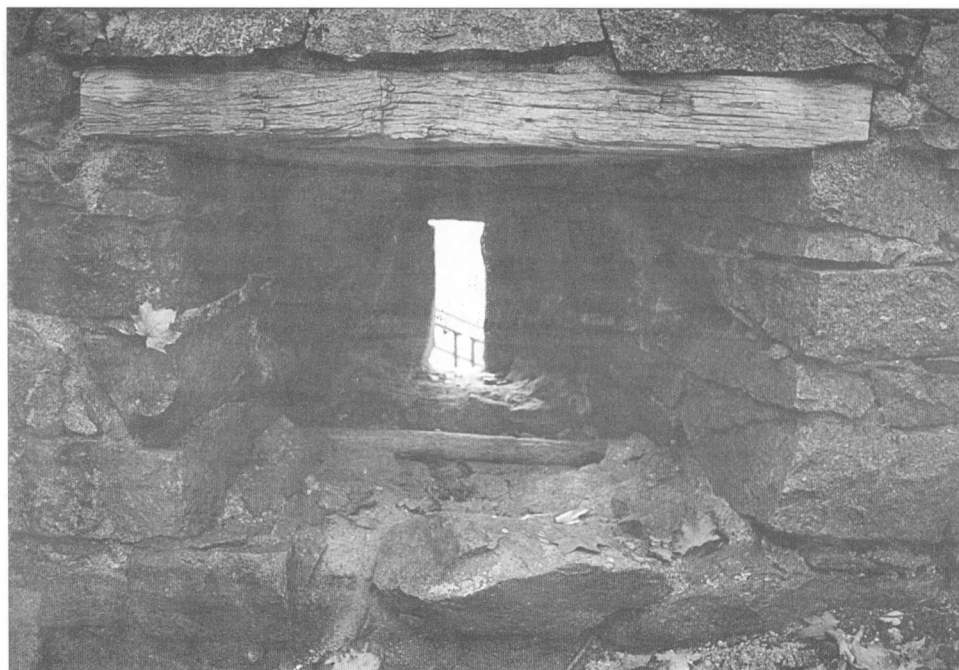
Obr. 7. Hrad Zvíkov, střelna pro hákovnici v parkánové hradbě z roku 1457. Foto J. Varhaník 1998.
