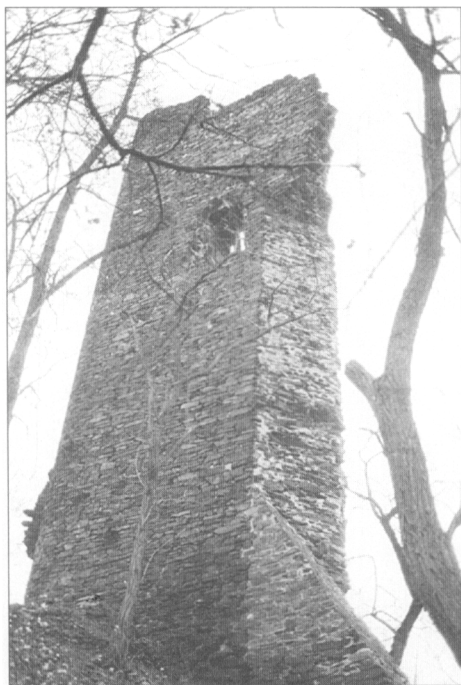
Obr. 5. Říčany. Vnější líc severozápadní stěny jihozápadního paláce. Vpravo otisk starší obvodové hradby, vlevo oblé nároží. Foto autor.
