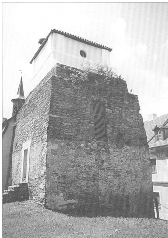
Obr. 8. Načeradec, věž-zvonice, pohled od severovýchodu, foto M. Glosová, 2003.
