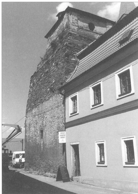
Obr. 6. Načeradec, věž-zvonice, západní strana, foto M. Glosová 1997.
