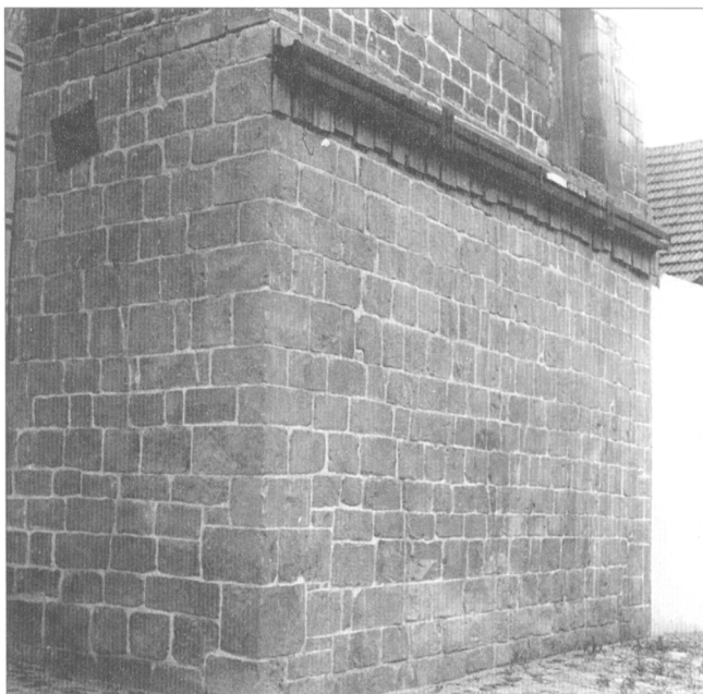
Obr. 5. Telč – spodní část věže kostela sv. Ducha od severozápadu po odstranění vnější obezdívky v r. 1990. V 1. patře západní stěny patrný (původní) vstup na věžní tribunu (foto L. Konečný).
