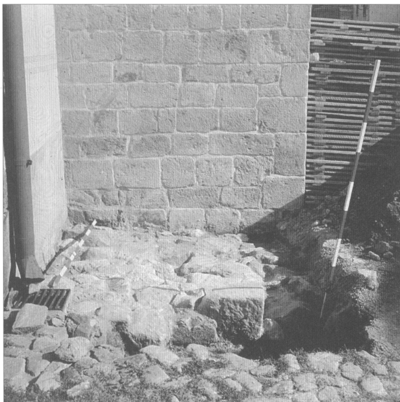
Obr. 18. Telč – severozápadní nároží věže kostela sv. Ducha s předstoupeným základovým zdívem (?) odkrytým v r. 1991 (foto J. Bláhy od SSZ).
