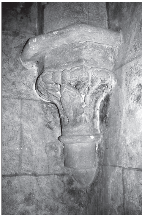
Obr. 2. Stará radnice – klenební konzola. Foto R. Viduna. Abb. 2. Altes Rathaus – Gewölbekonsole. Foto R. Viduna.
