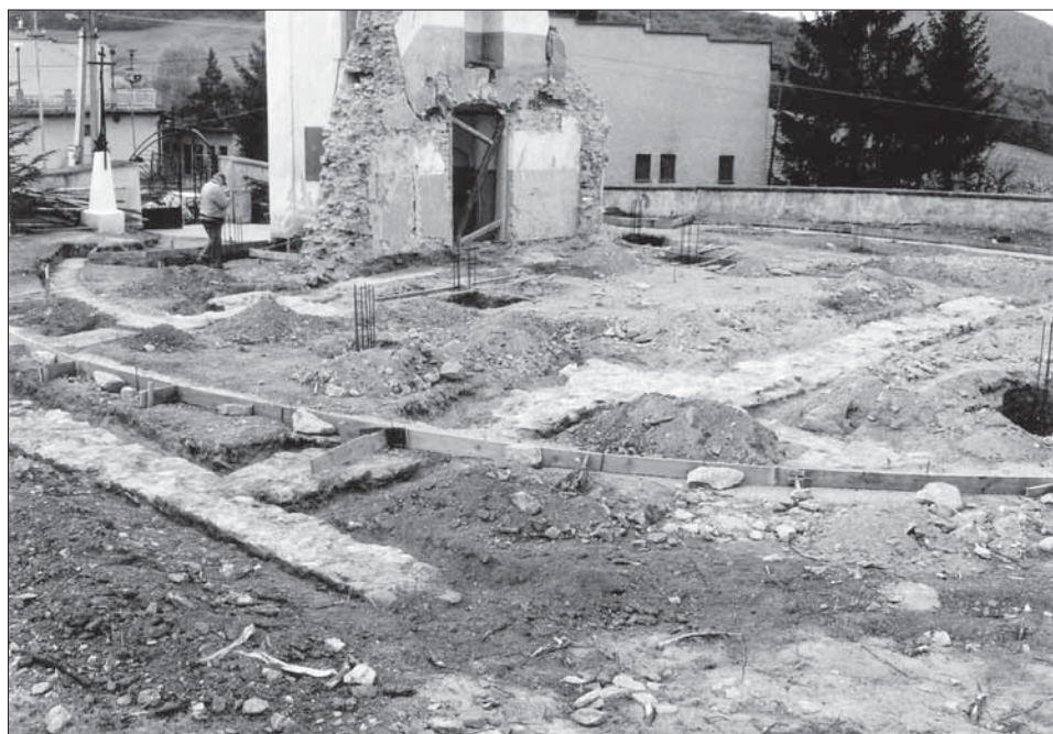
Obr. 3. Gregorovce, základy kostola od severovýchodu. Foto M. Uličný.
